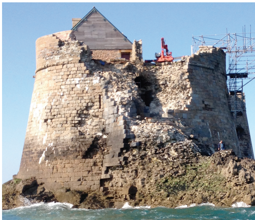
la grue télescopique en repliant ses bras devient peu visible sur le haut du rempart, contrairement à une grue classique à tourelle pivotante.
